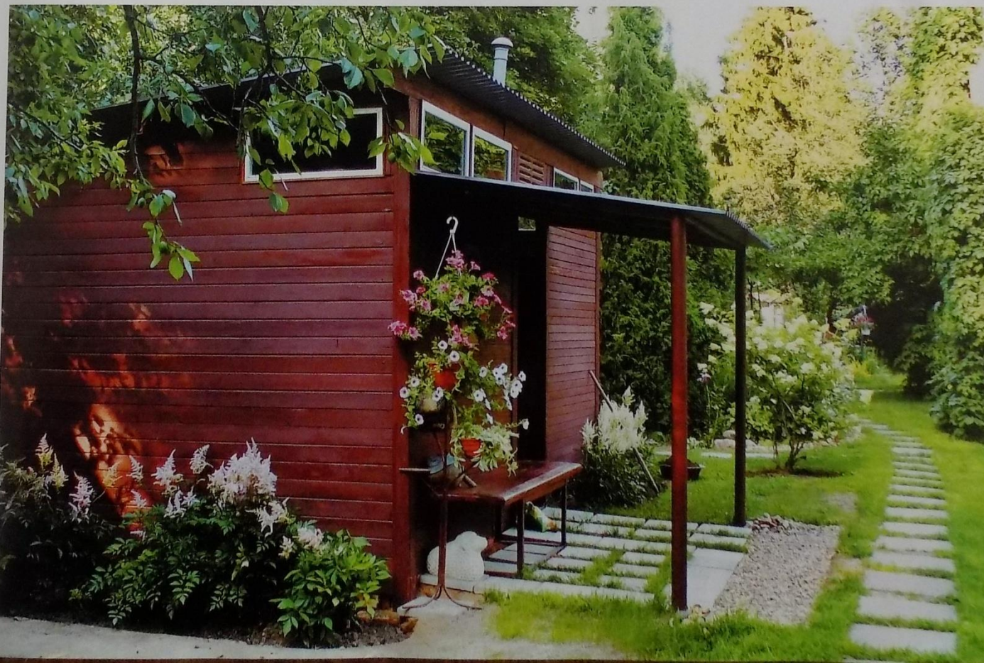
Рис. 16. Новостройка – долгожданный большой сарай, построенный из того, что было под рукой
